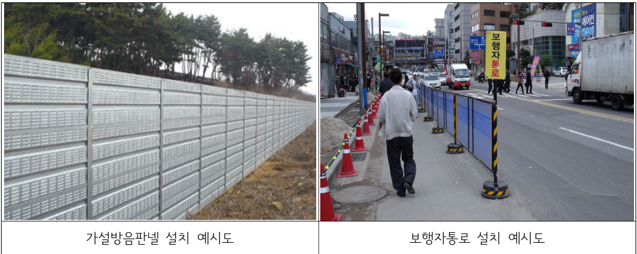
<표 3.4-2> 가설방음판넬 및 보행자통로 설치 예시
