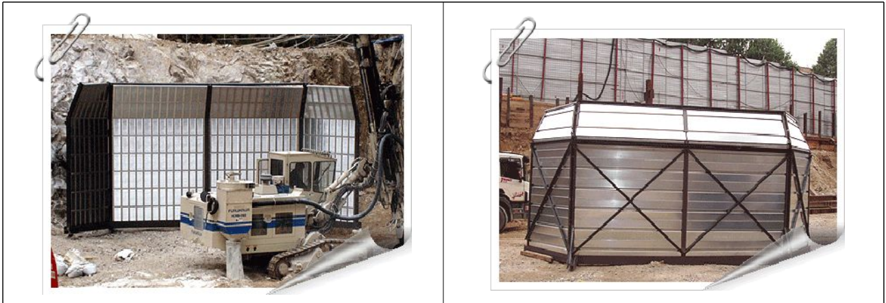
[그림 3.1-12] 이동식 가설방음판넬 설치 예시
